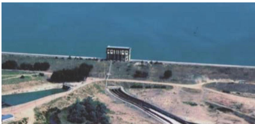
Рисунок 2.25 – Земляная плотина Тосоткельского водохранилища, оросительной системы реки Шу.
