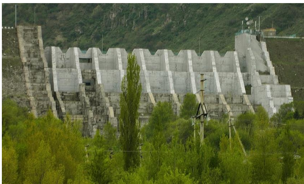
Рисунок 2.67 – Железобетонная ячеистая плотина в русле реки Талгар
