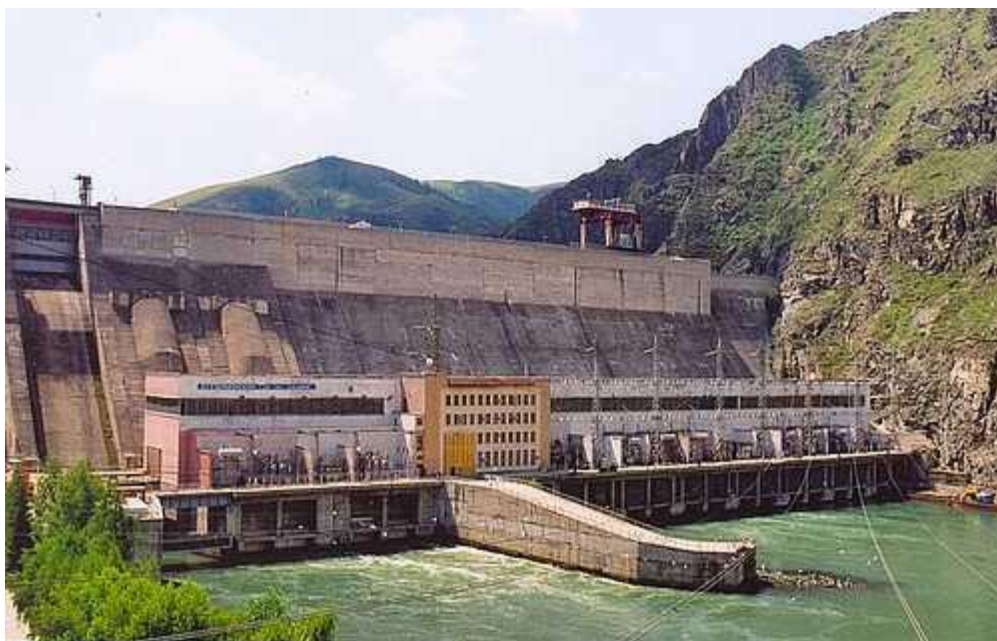
Рисунок 2.13 – Гравитационная плотина Бухтарминской ГЭС
