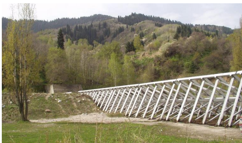
Рисунок 2.69 – Стальная сквозная селезадерживающая плотина на реке М. Алматинка
