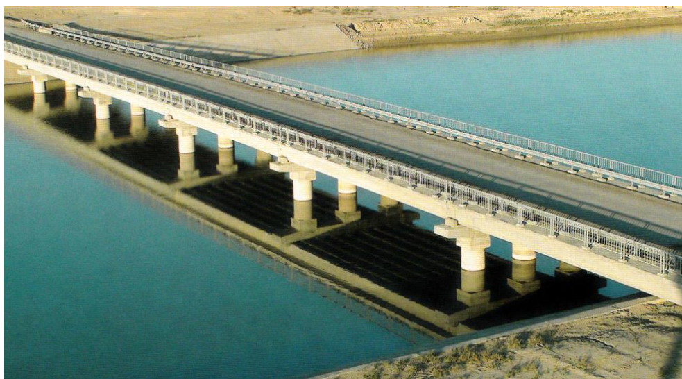
Рисунок 2.64 – Мостовой переход через отводящий канал Коксарайского контррегулятора
