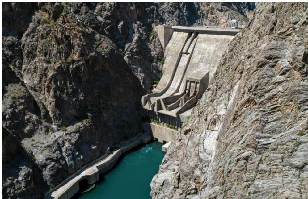
2.14 – Гравитационная плотина Токтогульского водохранилища
