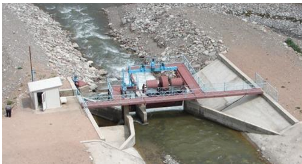
Рисунок 2.34 – Водозаборный гидроузел для деривационной ГЭС на реке Иссык-Ата в Кыргызской Республики
