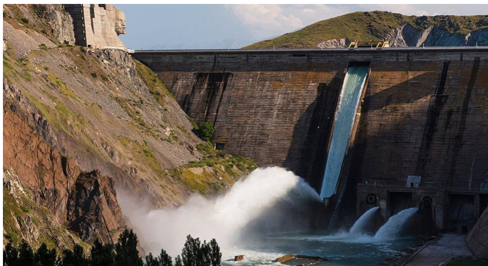
Рисунок 2.22 – Сброс воды в нижний бьеф плотины Кировского водохранилища с использованием поверхностного водосброса
