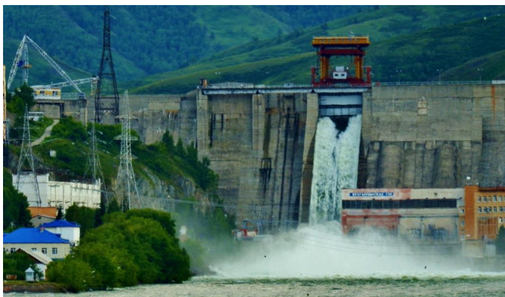
Рисунок 2.23 – Сброс воды в нижний бьеф Бухтарминской плотины
