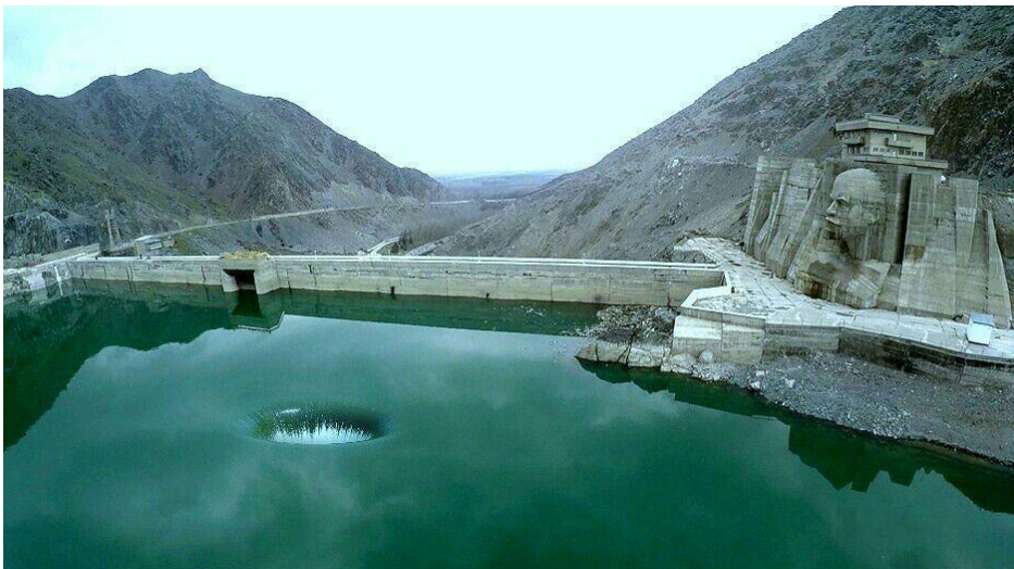
Рисунок 2.16 – Гребень контрфорсной плотины Кировского водохранилища
