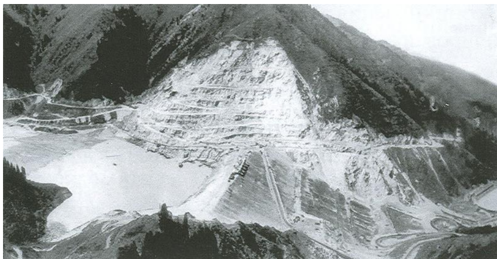
Рисунок 2.65 – Каменно-насыпная плотина в русле реки М. Алматинка – «Медео» с заполненной емкостью селехранилища в 15 июля 1973 года
