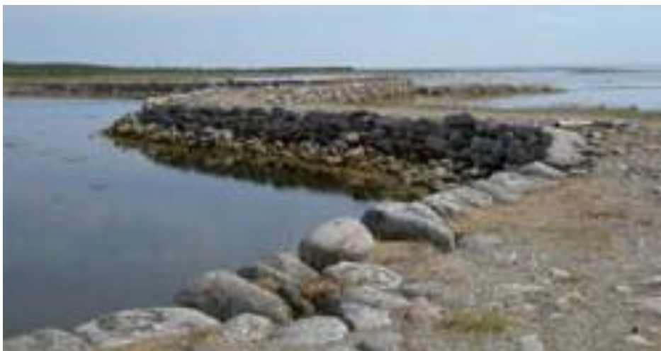
Рисунок 2.54 – Устройство струенаправляющей шпоры на долинном участке
