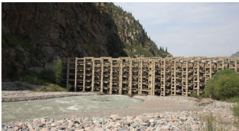
Рисунок 2.68 – Сквозная железобетонная плотина на реке Есик
